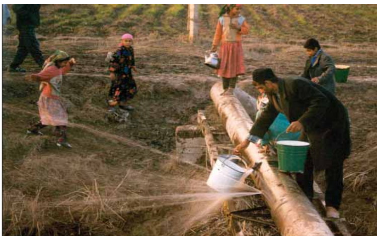
Рис 6. Проблемы с водоснабжением в Центральной Азии (© T. Divakova)
